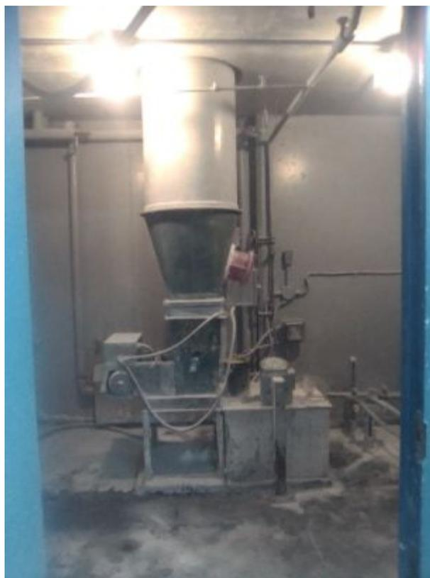
*Photo 7 : Réservoir de chaux*
