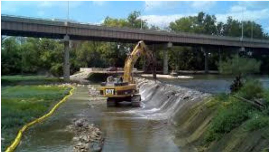
**Figure 13 - Brise-roche hydraulique implanté sur le bras articulé d'une pelleuse qui détruit un petit barrage (Ghitzhusen, 2012)**
