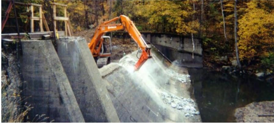
**Figure 19 - Démolition de la structure en béton par un marteau piqueur hydraulique installé sur une pelleteuse (USSD, 2015)**
