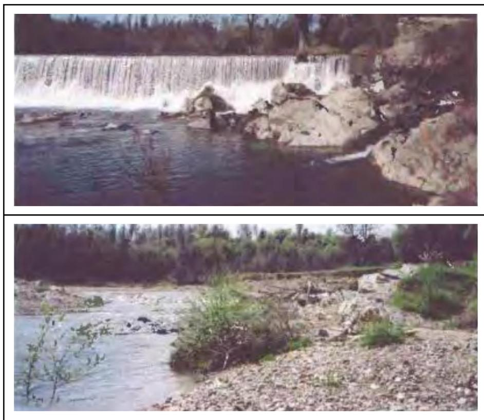
**Figure 17 - Photographie du barrage Saeltzer avant et après démolition (USSD, 2015)**
