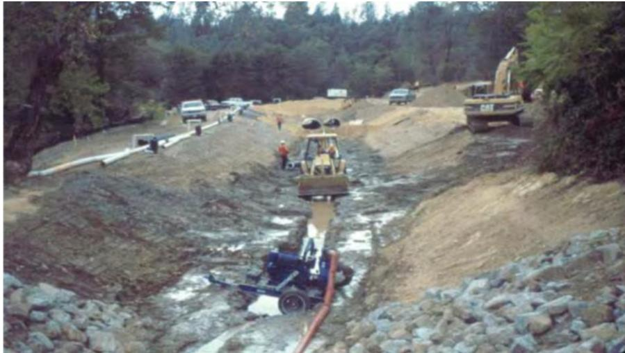
**Figure 16 - Canal de dérivation construit pour le démantèlement du barrage Saeltzer et l'enlèvement des sédiments contaminés (USSD, 2015)**
