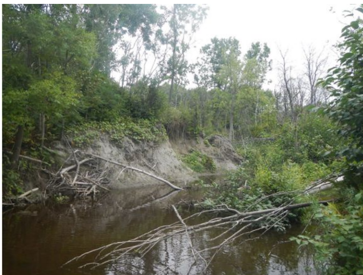
Figure 5: Zone de décrochement importante dans le secteur Valéro (Rivière des Coutures) – Juillet 2020
