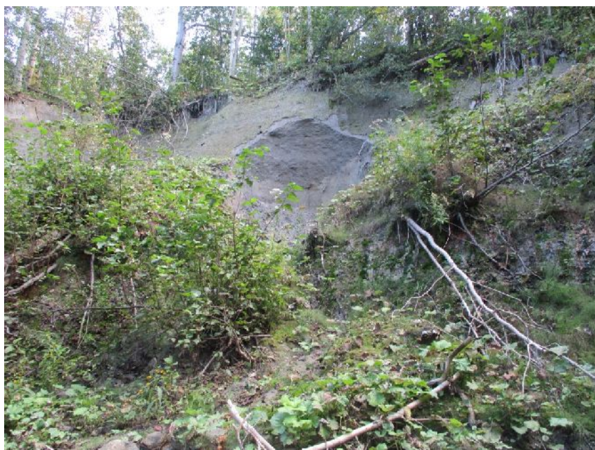
Figure 6: Zone de décrochement en cours de revégétalisation dans le parc Valéro – Juillet 2020
